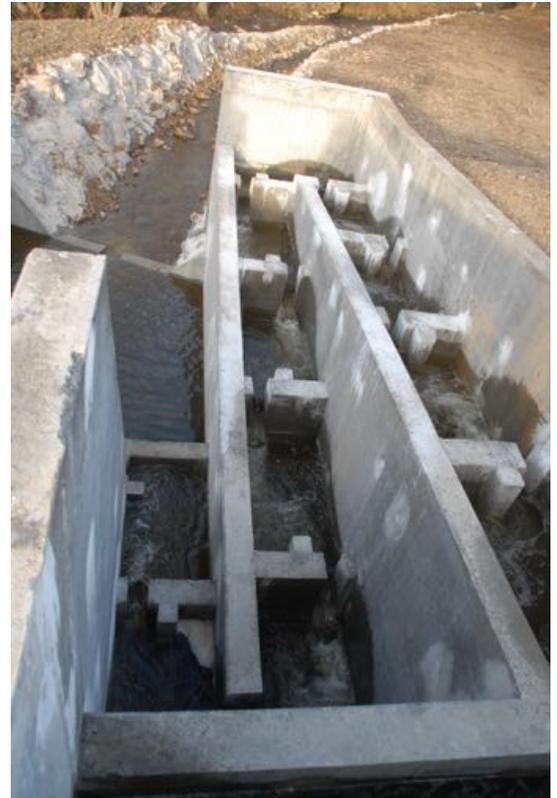
Le dénivelé du terrain a également impliqué la construction d'une échelle à poissons.
